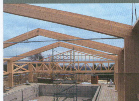
Une vue de la charpente porteuse.
