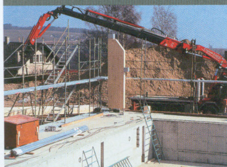
Fixation des piliers de la charpente.
