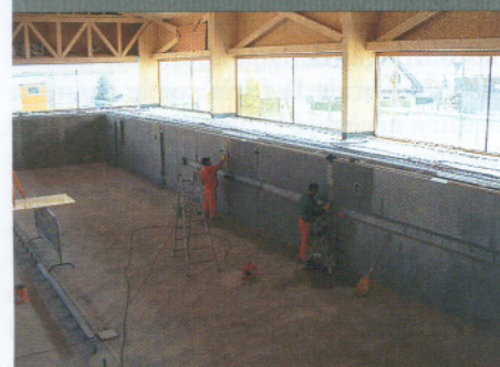
Le lissage de la surface de béton du bassin.
